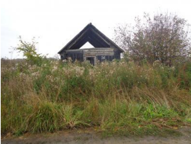
Фото 3. Д. Юльяновка, ул. Центральная, 34. Дом Рудольфа Гизс (нежилой). 20 сентября 2015 года.
